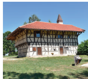
Communauté d'Agglomération du Bassin de Bourg-en-Bresse - Rénovation de la Ferme de la Forêt à Courtes
