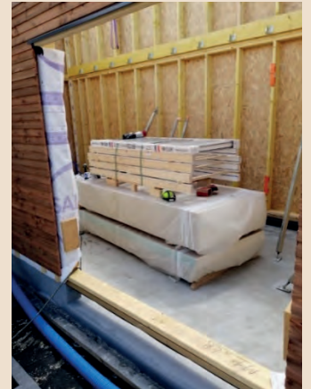
Gestion optimisée de l'approvisionnement des matériaux « lourds » en phase de gros œuvre
