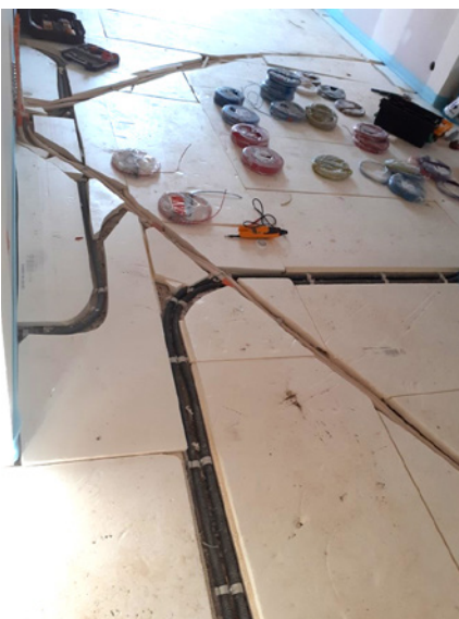
Pose non conforme d'une sous-couche isolante
